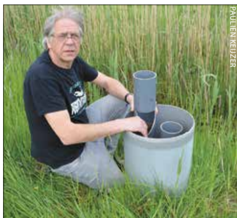
Wim Thomassen bij een van de uitlooppijpen.
