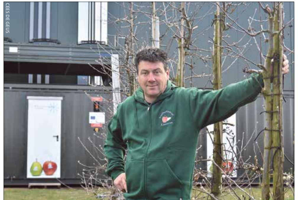
Hans van der Wind is tevreden over de nieuwe koelinstallatie, die gebruikmaakt van de combinatie propaan/CO 2 . 'Koeltechnisch ziet het er heel goed uit.'
