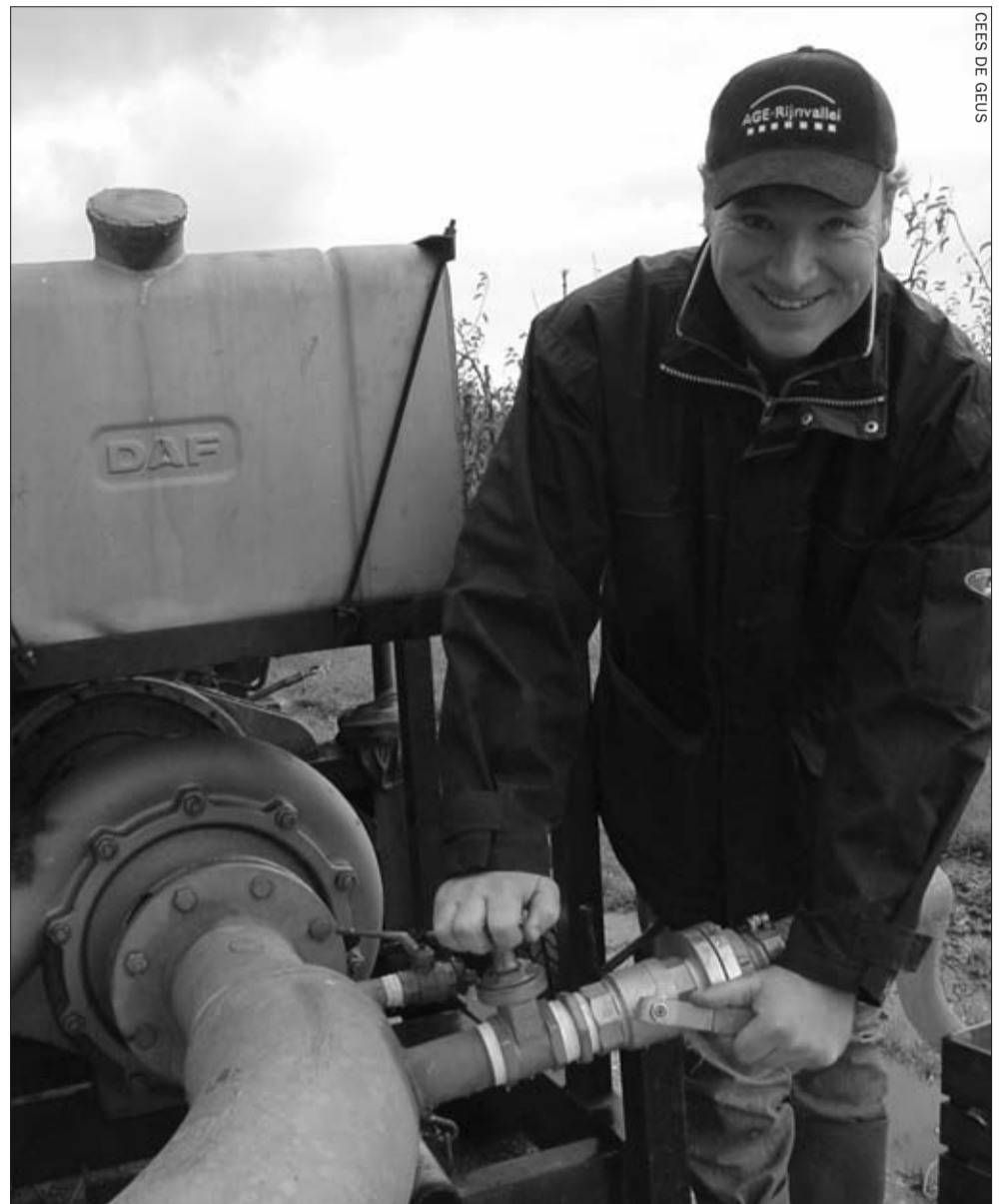
Jos van Rijn bij de beregeningspomp, die is uitgebreid met voorzieningen om de verspreiding van kalkmelk mogelijk te maken.
