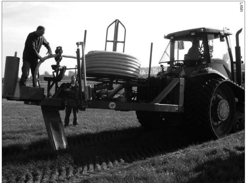
Demonstratie van de aanleg van onderwaterdrains bij melkveebedrijf Hans van Leeuwen op 17 oktober. De afbraak van veengrond is mogelijk te beperken door infiltratie van slootwater via drains.
