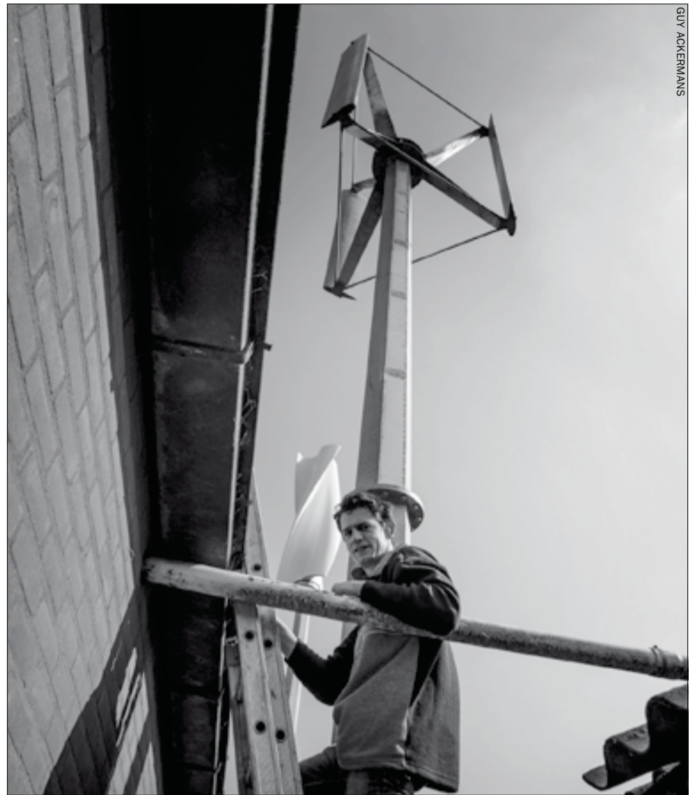
Melkveehouder Bart van Laar bij de net geïnstalleerde windturbines.
